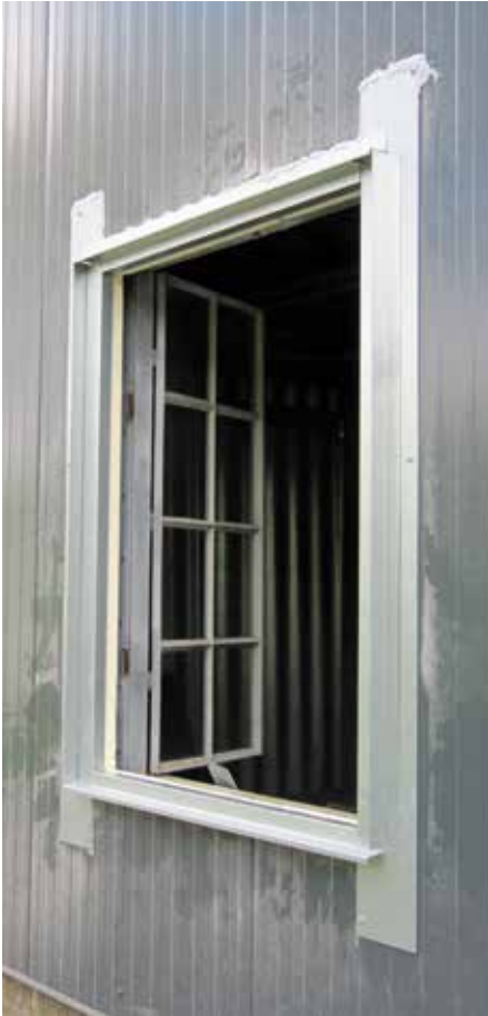
Zetwerk en staalplaat voor bevestiging oude luiken.
