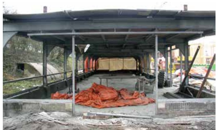
Gestript, schoongemaakt, opnieuw verzinkt en herbouwd.
