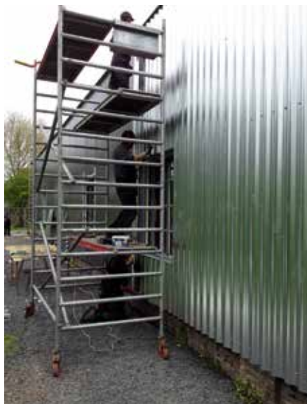
De pir-panelen zijn enkel onderaan op de borstwering en boven aan een koker gemonteerd.
