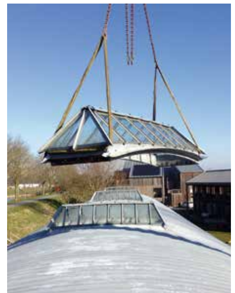
Op het dak bevinden zich vier daklichten. Oorspronkelijk staat in de tussenbeuk zonder daklicht een metalen ventilatieschoorsteen.
