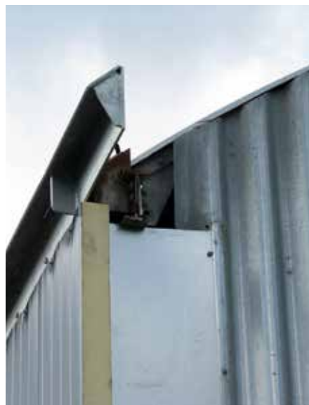
Bij doorstekende delen meer staal binnen dan buiten. Opwarming/uitstraling voorkomt koudebruggen.
